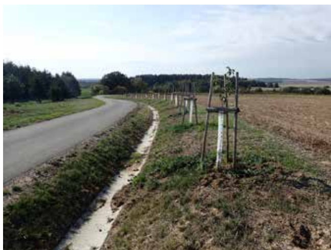
Obr. 109 Ukázka realizace polní cesty s odvodňovacím příkopem a liniovou výsadbou (zdroj: SPÚ)
