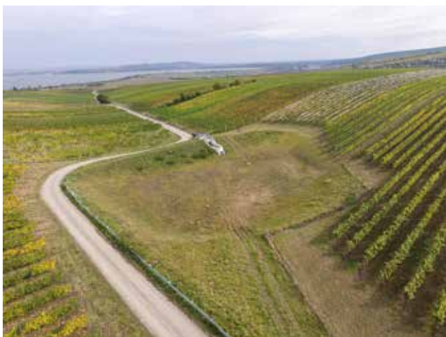
Obr. 112 Ukázka realizace protierozní sedimentační nádrže (zdroj: SPÚ)
